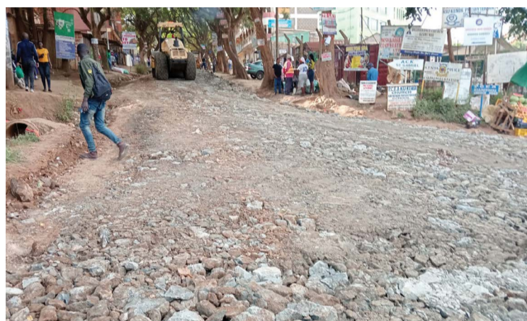
Construction of Kiuu Kenda road Township Ward, Kiambu.
